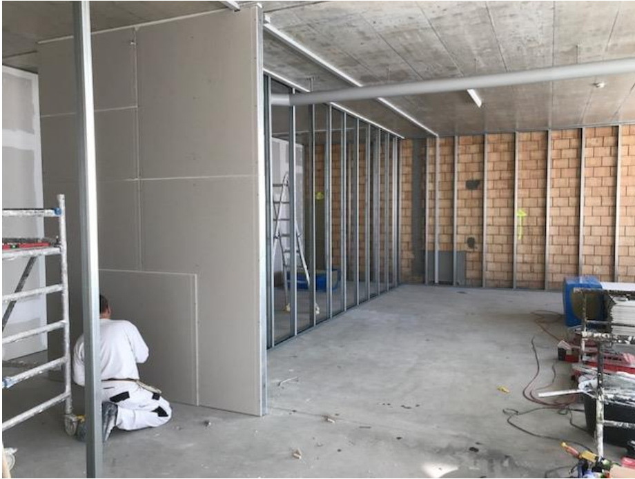
Leichtbauwände und Vorsatzschalen
